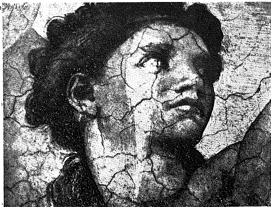
Rys. 6. Rysy na tynku wapiennym pod malowidłem M. A. Buonarotti
